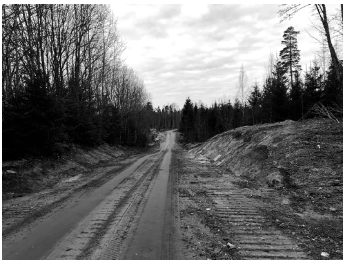
Remontdarbi uz pašvaldības autoceļa B74 "Brežģis – Runtis".
