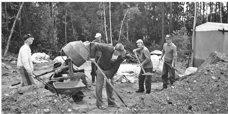
90.-tie gadi. „Balgas” vīri veic Vecpiebalgas benzīntanka betonēšanas darbus.
