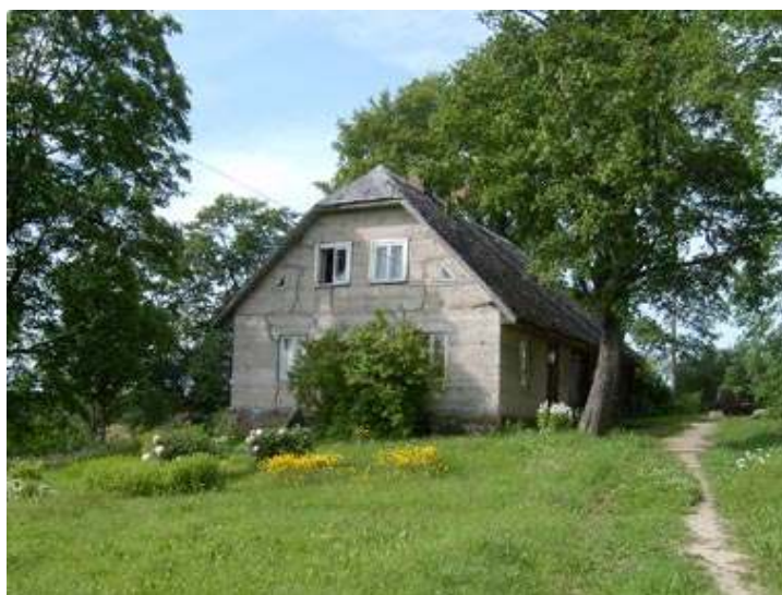
2.12.attēls. A.Austriņa memoriālais muzejs „Kaikaiši”. Foto no www.vecpiebalga.lv
