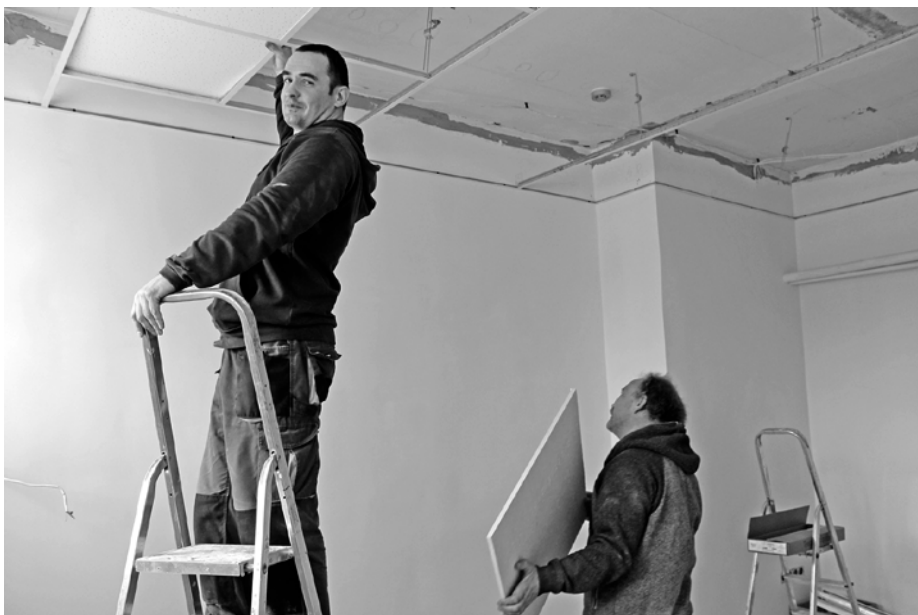
Remontdarbus, lai izveidotu pievilcīgu un funkcionālu logopēda kabinetu Vecpiebalgas bērnudārzā, veic pašvaldības Saimniecības daļas darbinieki Aivis Kurpnieks un Aigars Zvejnieks.
